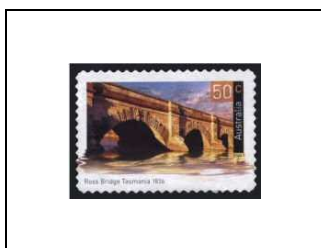
Pont Ross, Tasmanie, 1836
