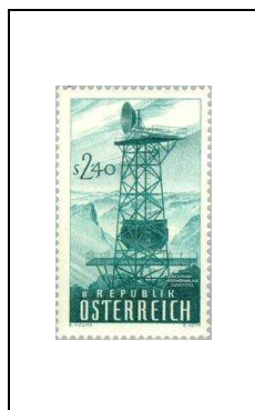
Inauguration du réseau hertzien
