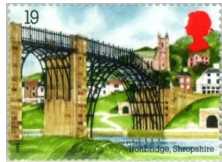
Pont métallique sur la Severn, à Coalbrookdale (Shrapshire)
