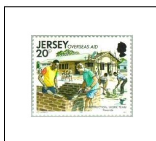
Construction d'habitations au Rwanda
