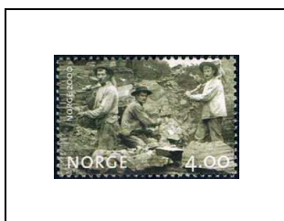
Ouvriers travaillant à la construction d'une ligne de chemin de fer (début du siècle)
